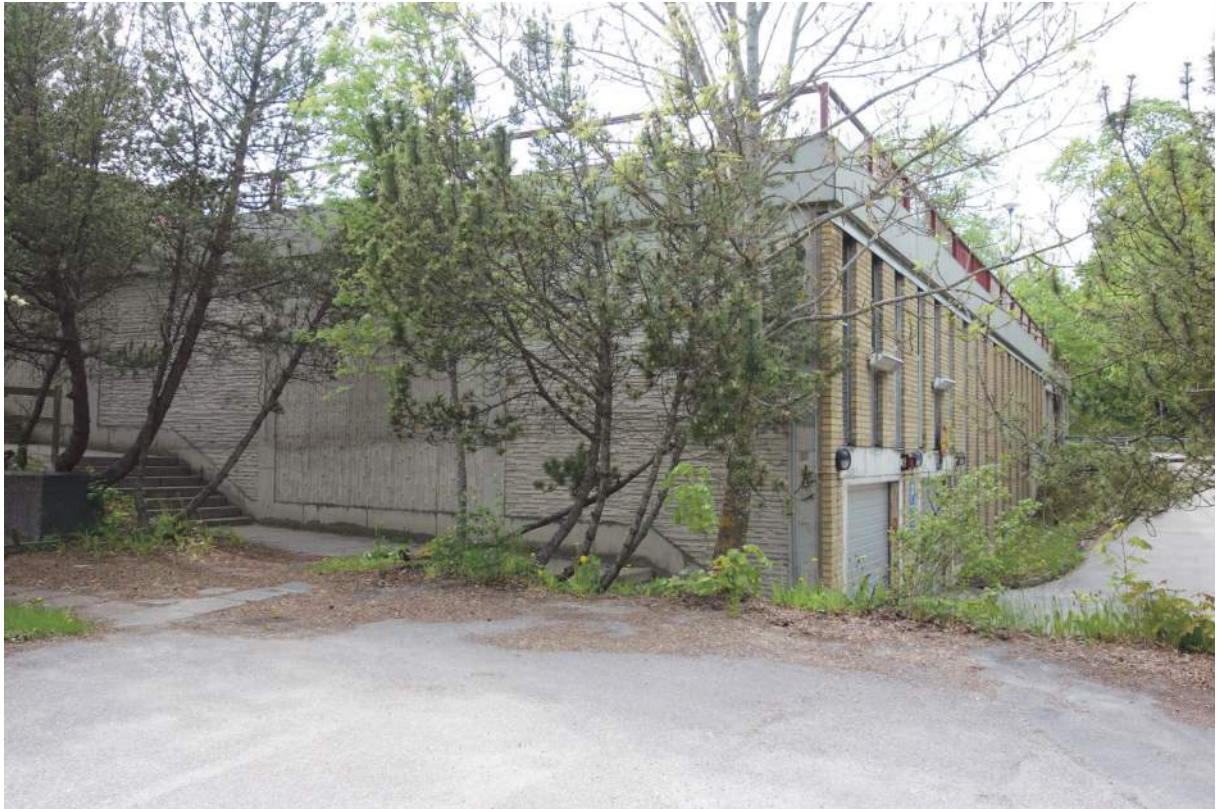
Parkeringshuset på anslutande fastighet i väster sett från Hotellet 5:s gårdsyta. Parkeringshuset är byggt i suterräng och taket med parkeringsdäck ligger i nivå med Vallonvägen som ansluter i söder (Fredriksson arkitektkontor 2022).
