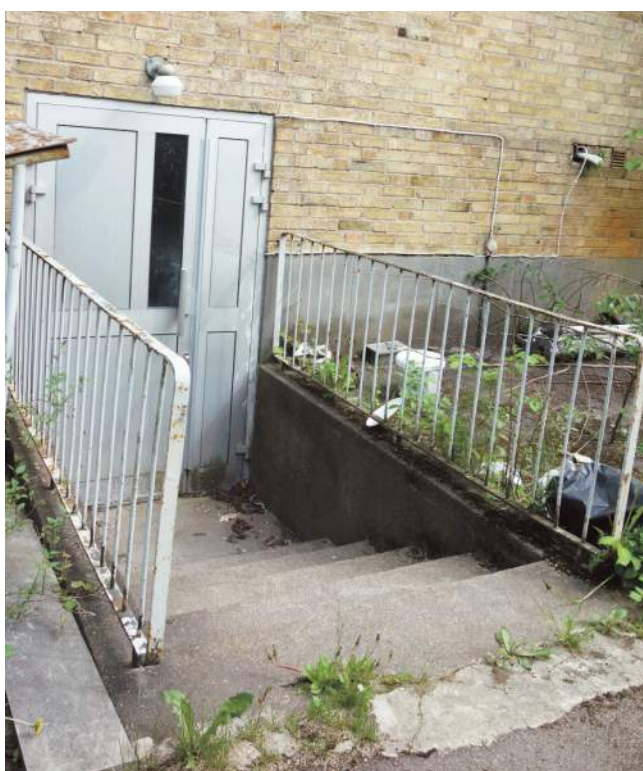
Källarentré i den ursprungliga byggnadens gårdsfasad mot väster. Räcke av rund- och plattjärn är ursprungligt medan aluminiumdörrpartiet är sentida (Fredriksson arkitektkontor 2022).
