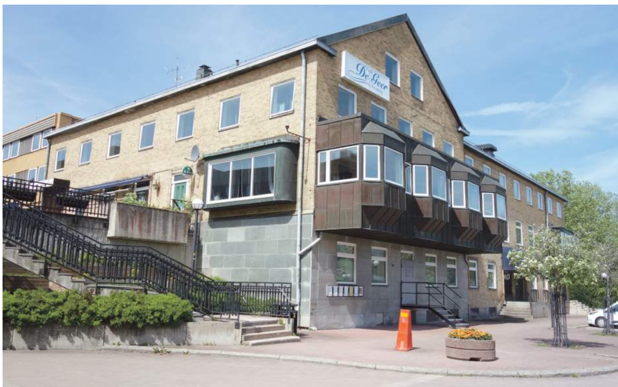
Fasad mot öster och söder från sydöst. Den ursprungliga balkongen på östra fasaden har byggts om till ett stort och kraftfullt burspråk som tillåts att dominera huvudfasaden på bekostnad av originalarkitekturen. Terrassmuren och trappan till vänster i bild har tillkommit senare (Fredriksson arkitektkontor 2022).
