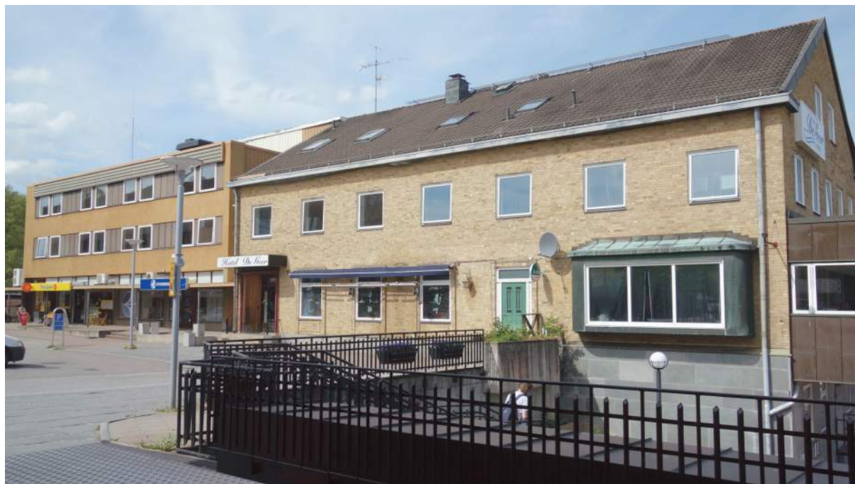
Den ursprungliga hotellbyggnaden från 1952 till höger i bild. Till vänster mot den västra gaveln ansluter tillbyggnaden från 1974 (Fredriksson arkitektkontor 2022).
