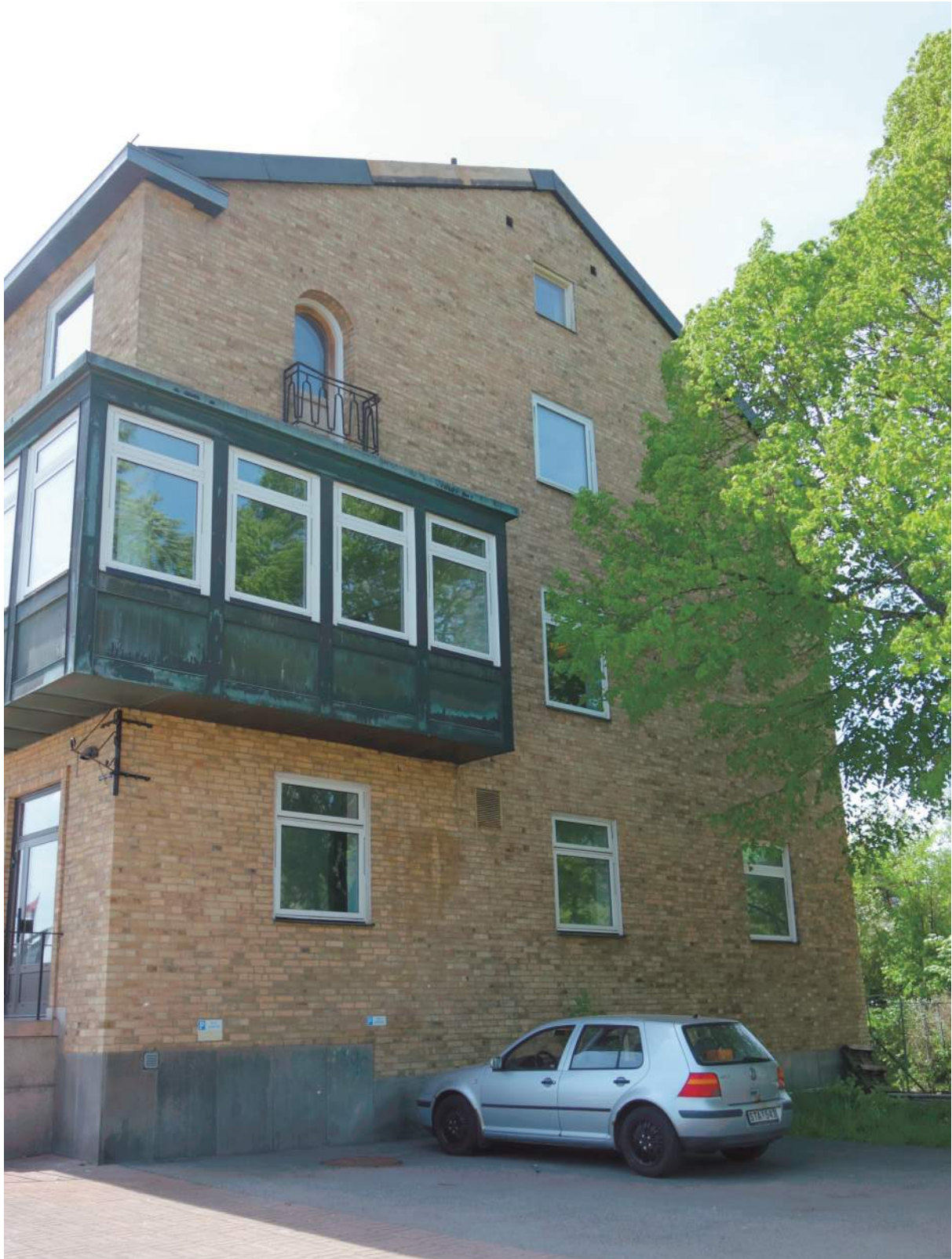
Den ursprungliga byggnadens norra gavel med kopparklätt burspråk som löper över knuten och vidare ut på fasad mot öster och torget. Notera även den franska balkongen med rundbågig dörr i ädelträ och tidstypiskt smitt räcke (Fredriksson arkitektkontor 2022).
