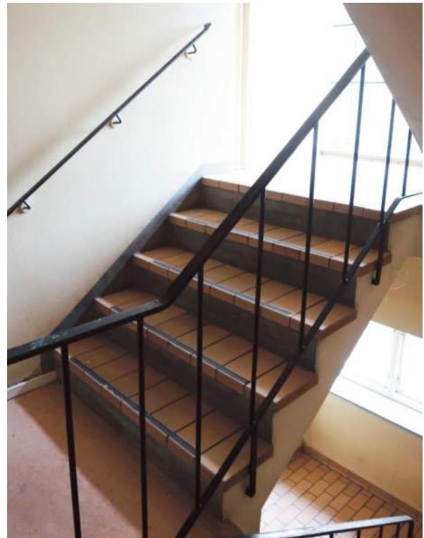
Trappa i byggnadens mitt mot västra fasaden (Fredriksson arkitektkontor 2022).
