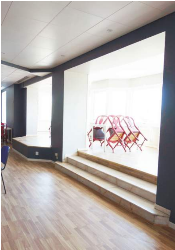
Plan 1 tr. Restaurangdel på plan 1 mot östra ytterväggen. Öppning ut mot det stora sekundära burspråket. Ytskikten är sentida (Fredriksson arkitektkontor 2022).
