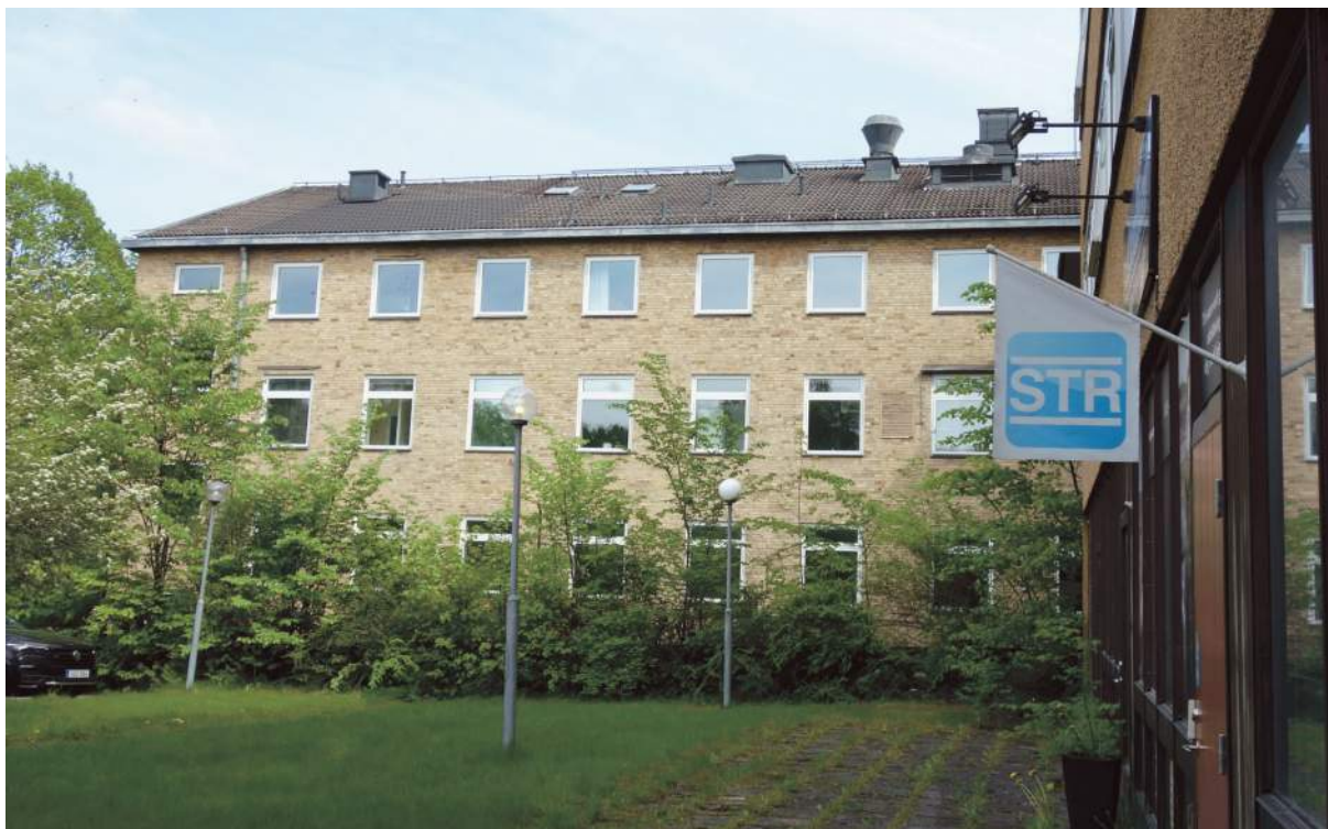
Den ursprungliga byggnadens gårdsfasad mot väster. Det mörkare partiet i takfallet visar var en ursprunglig pisekbalkong har satts igen och kompletterats med nytt taktegel. En mängd olika huvar och don förekommer (Fredriksson arkitektkontor 2022).
