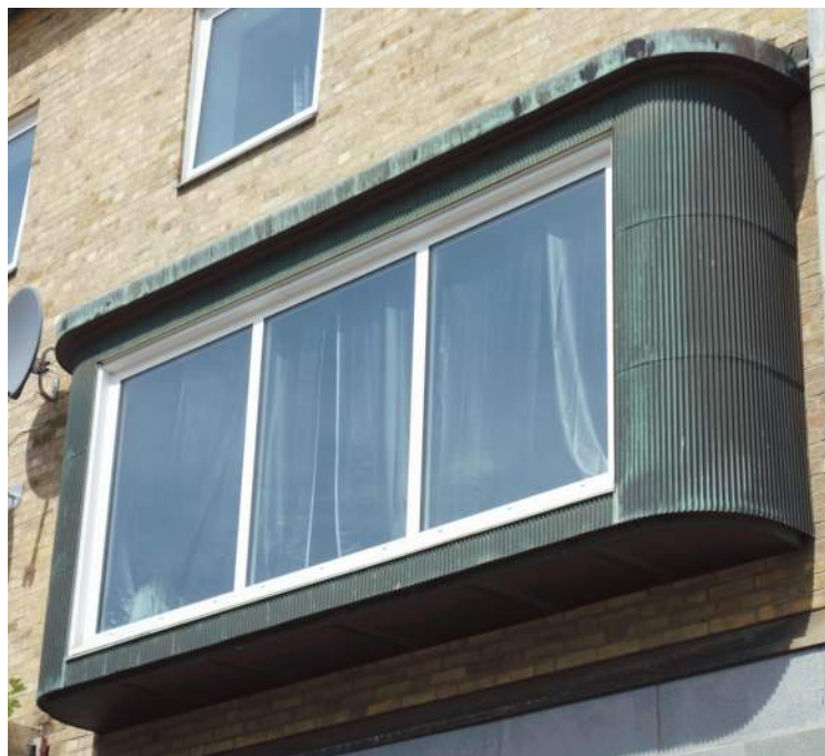
Ursprungligt kopparklätt burspråk i södra fasaden. Notera plåtens räfflade utseende som liknar dåtidens populära smala karosseripanel (Fredriksson arkitektkontor 2022).
