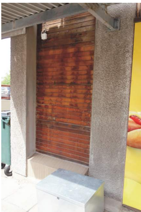
Fasad i bottenplan är spritputsad. Den kraftigt utkragade sockeln är klädd med brun klinker. Dörrpartier och skyltfönstrens karmar är utförda i ädelträ (Fredriksson arkitektkontor 2022).
