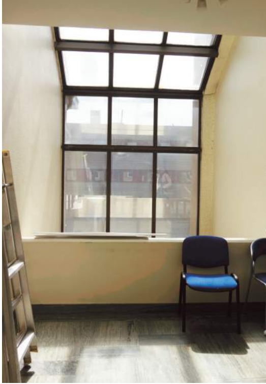
Glasparti i söderläge i den mindre byggnadskropp som sammanlänkar tillbyggnaden med ursprunglig byggnad. (Fredriksson arkitektkontor 2022).
