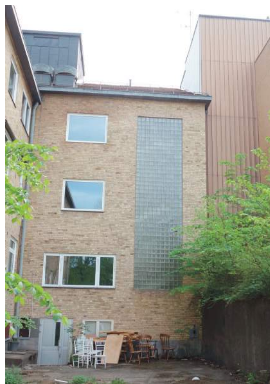
Den ursprungliga byggnadens gårdsfasad mot norr med karaktärsskapande och tidstypiskt trapphusfönster i betongglas. Entrédörren i aluminium är sekundär och utan kulturvärde (Fredriksson arkitektkontor 2022).
