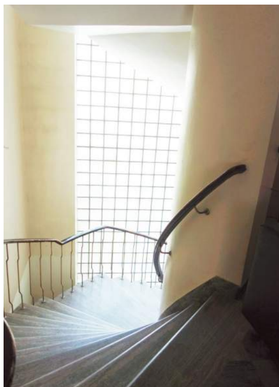
Huvudtrappa i anslutning till entréhallen. Plan- och sättsteg i kolmårdsmarmor. Ursprungliga räckan och handledare. Ljussläpp i form av högt trapphus fönster med betongglas (Fredriksson arkitektkontor 2022).
