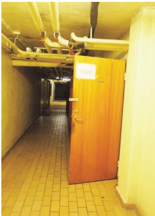
Källarvåning, korridor med klinker (Fredriksson arkitektkontor 2022).
