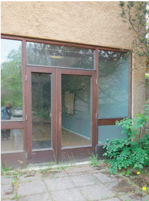
Suterrängvåningen mot gården är försedd med ett glasat parti med ramverk och dörr i ädelträ (Fredriksson arkitektkontor 2022).
