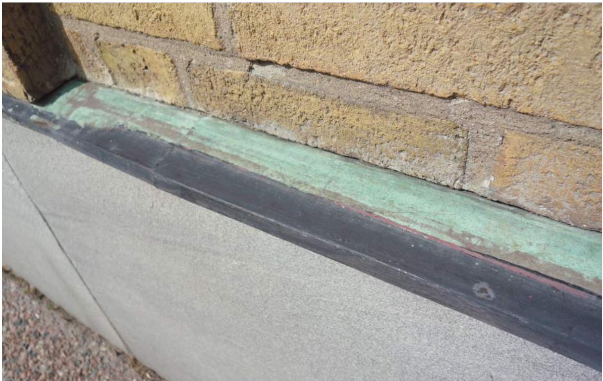
Sockeln längs södra fasaden är avtäckd med en kopparplåt som senare har målats svart. Koppardetaljer är karaktäristiskt för 1950-talets arkitektur och utgör en mycket viktig del av byggnadens ursprungliga uttryck och gestaltning. Notera även murstensens ylbearbetning och exakta kulör som också bidrar till fasadernas uttryck. Sockeln är klädd med skivor av ljusgrå natursten (Fredriksson arkitektkontor 2022).
