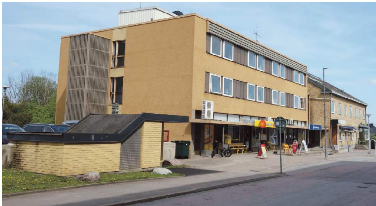
Tillbyggnaden från 1972. Fasad mot söder och väster. Fasaderna är putsade och avfärgade i en ockrakulör. På västra gaveln finns en utanpåliggande panelklädd utrymningstrappa. Entrévåningen i söder rymmer butiker med skyltfönster (Fredriksson arkitektkontor 2022).
