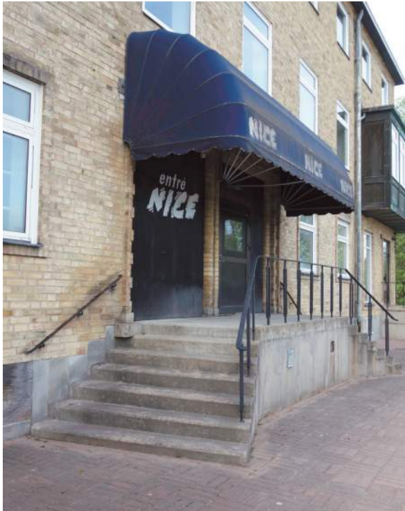
Huvudentré i östra fasaden. Trappa och räcken är ursprungliga. Dörrparti och skivmaterial i dörröppning är sentida. Ursprungliga, nu rivna partier satt indragna i fasaden (Fredriksson arkitektkontor 2022).
