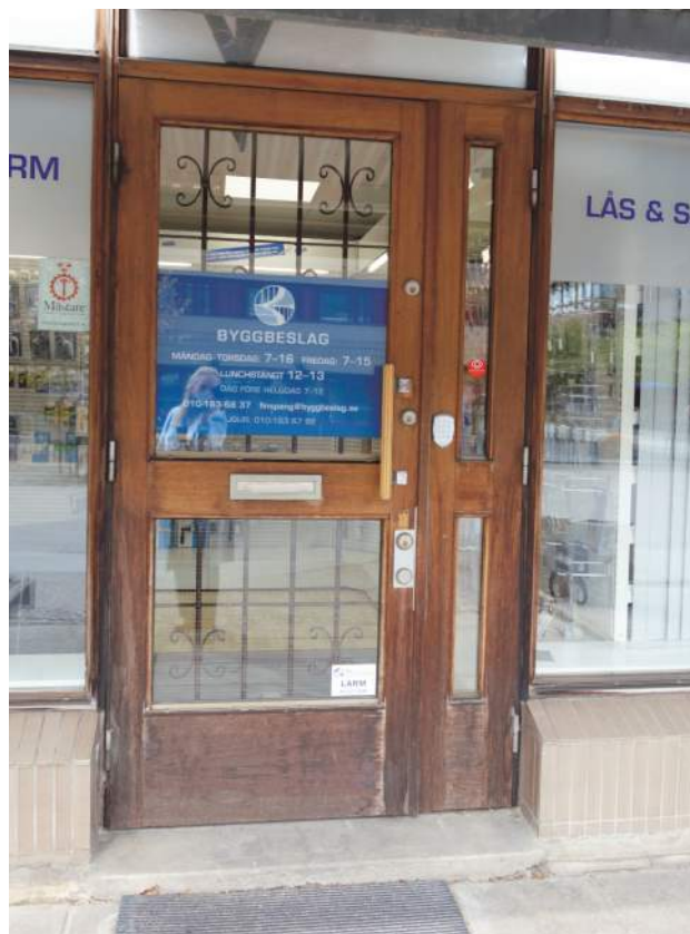
Fasad i bottenplan är spritputsad. Den kraftigt utkragade sockeln är klädd med brun klinker. Dörrpartier och skyltfönstrens karmar är utförda i ädelträ (Fredriksson arkitektkontor 2022).
