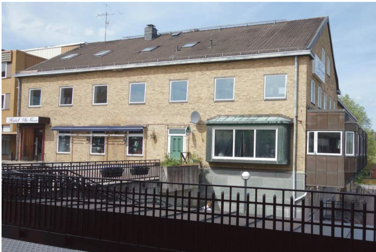
Den ursprungliga byggnadens fasad mot söder. På taket har ursprungligt rött lertegel ersatts av gråsvart betongtegel. Det rundade burspråket är original medan det till höger i bild är sekundärt och där ersatte en ursprunglig balkong (Fredriksson arkitektkontor 2022).
