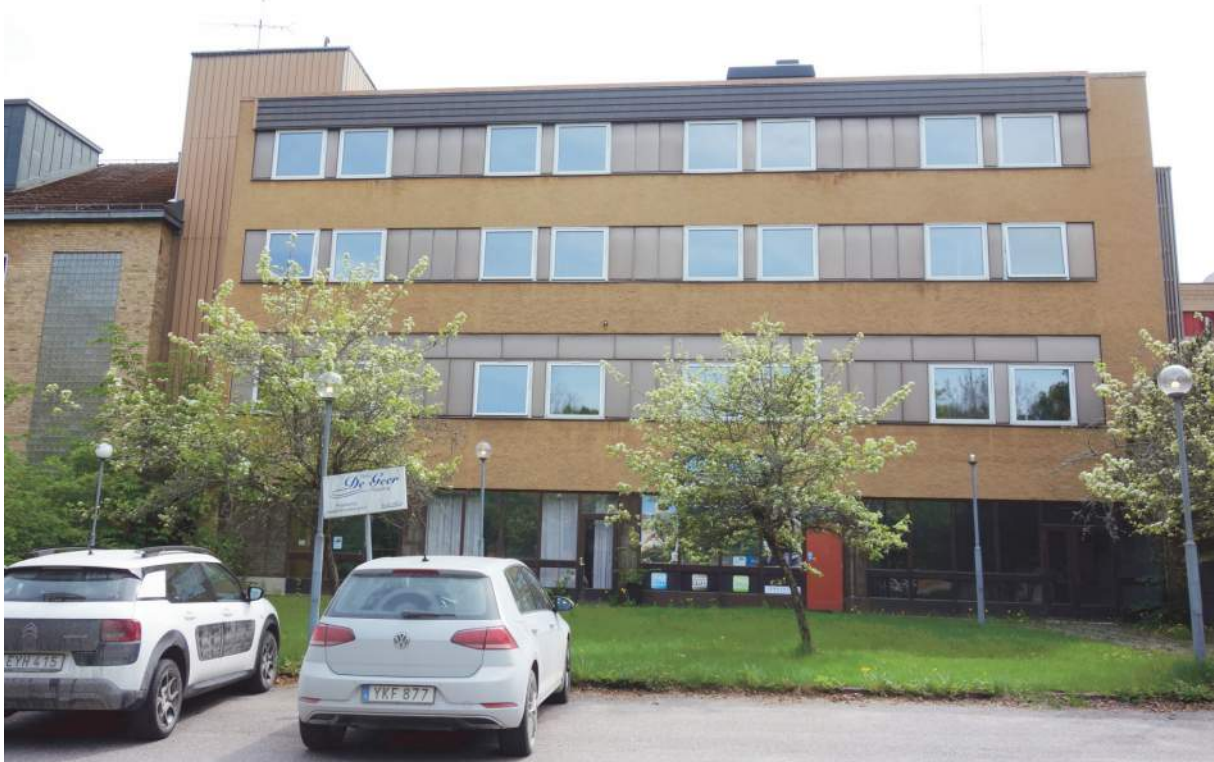
Den tillbyggda delens gårdsfasad mot norr. Den mötande/sammanlänkande volymen mellan den ursprungliga byggnaden och tillbyggnaden är plåtklädd (Fredriksson arkitektkontor 2022).
